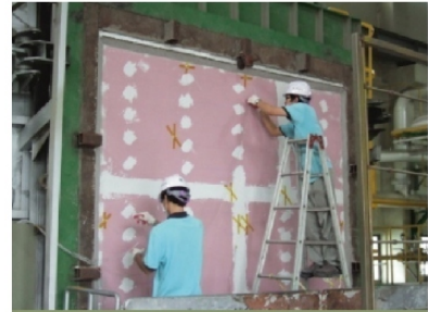
벽체 비가열면 온도측정센서 설치
